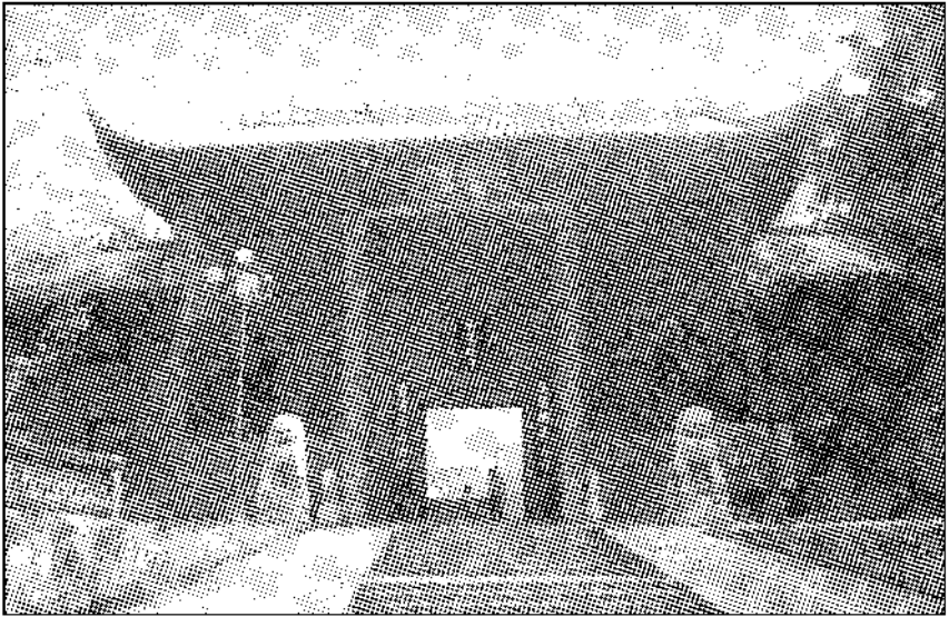
曹溪門—南華寺第一度山門
